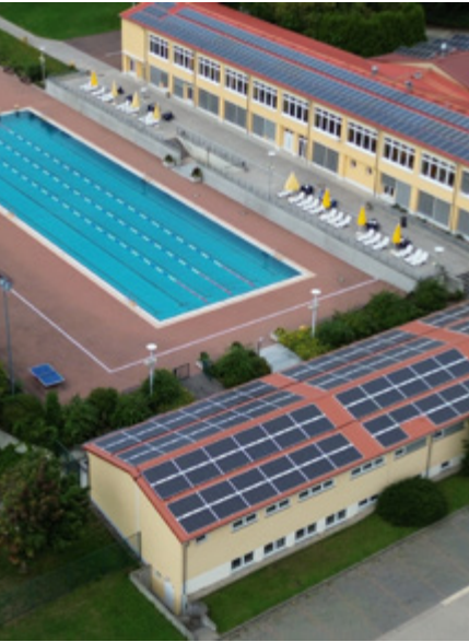
Die Solaranlagen unterstützen den Freibadbetrieb vor allem in den besucherstarken Sommermonaten. Foto: Stadtwerke Eisenberg Energie GmbH
